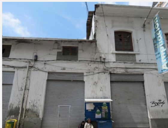
FACHADA CALLE COMERCIO
