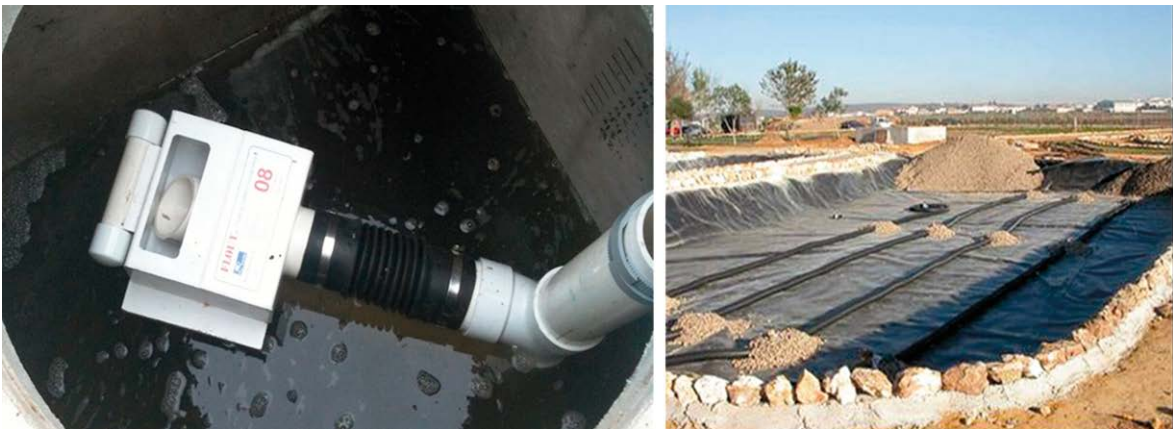
Figura 7.82. Izda.: Sifón de autodescarga (Rissy Plastics). Dcha.: Tuberías de drenaje.
