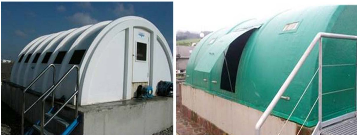
Figura 7.176. Distintos tipos de cubiertas para Contactores Biológicos Rotativos.
