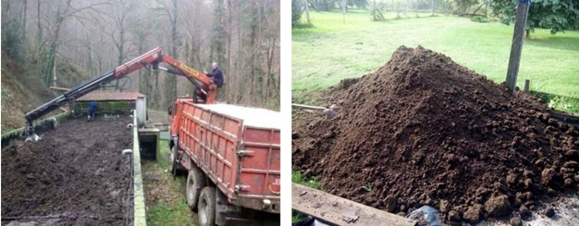
Figura 7.106. Retirada de la capa superior de un Lombrifiltro y aspecto del material humificado tras un periodo de maduración.
