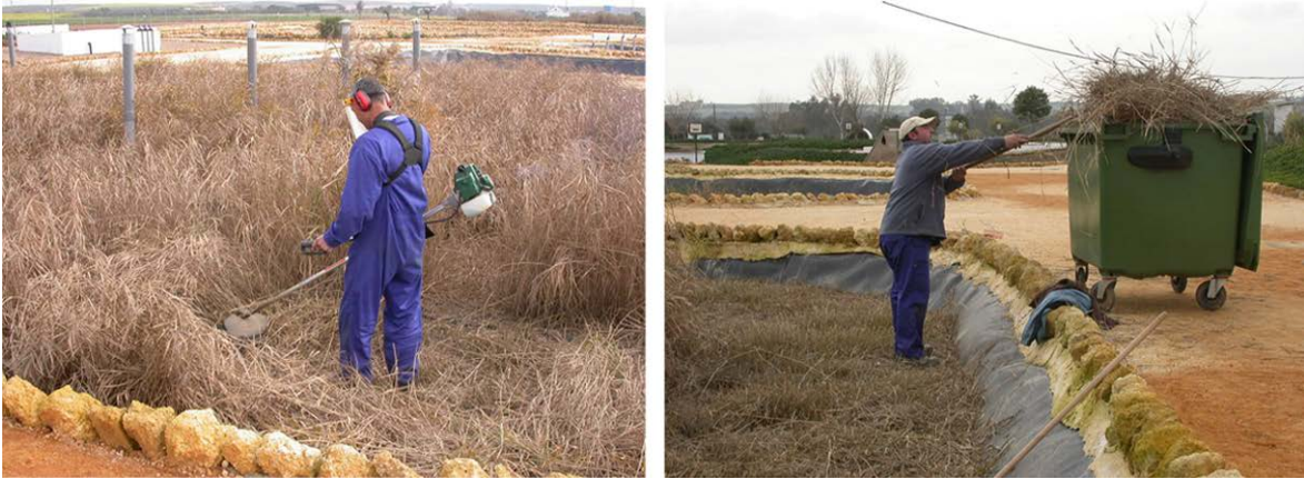
Figura 7.84. Siega de la vegetación de los Humedales Artificiales de Flujo Subsuperficial y evacuación de la misma.
