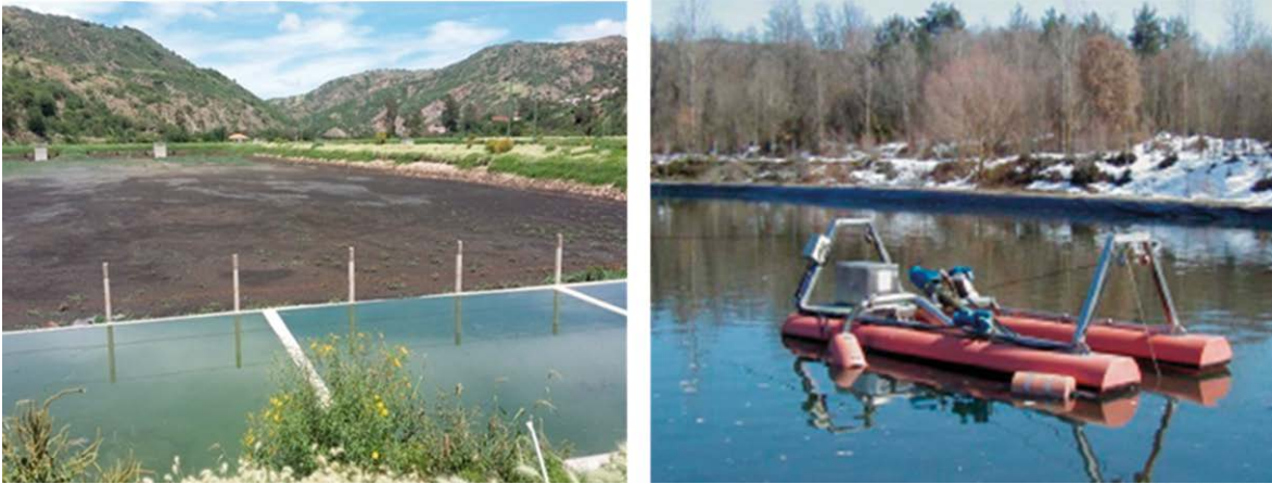
Figura 7.60. Extracción en seco y húmedo de lodos acumulados en lagunas.
