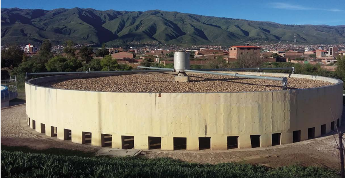
Figura 7.109. Filtro Percolador de la PTAR de El Abra, Sacaba (Bolivia).
