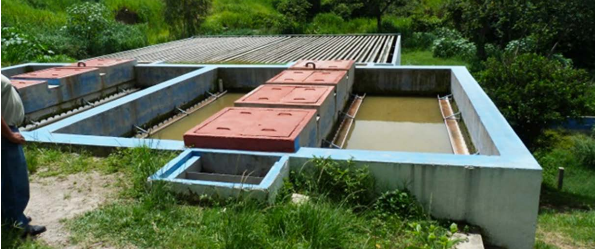
Figura 7.20. Reactores Anaerobios de Flujo Ascendente seguidos de Filtro Percolador en la PTAR de Ciudad Futura (El Salvador).
