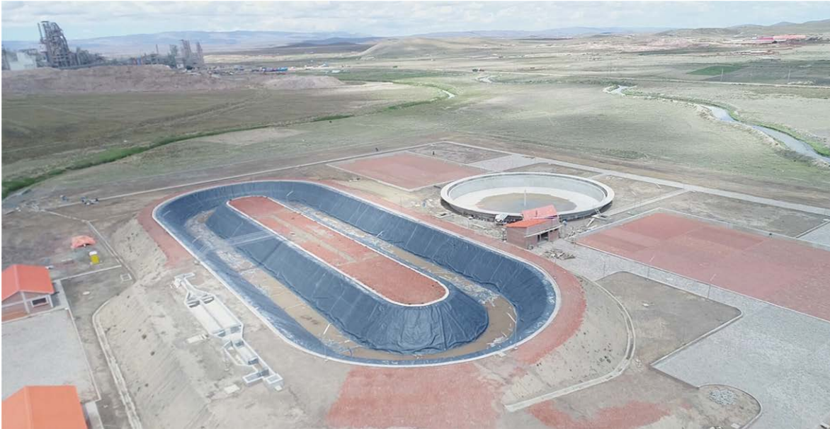
Figura 7.185. Canal de oxidación en la PTAR de Viacha (Bolivia) en construcción.
