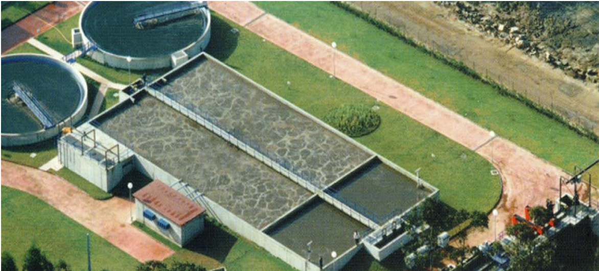
Figura 7.180. PTAR de Aireación Extendida (Cambados y Vilanova de Arousa, Pontevedra, España).
