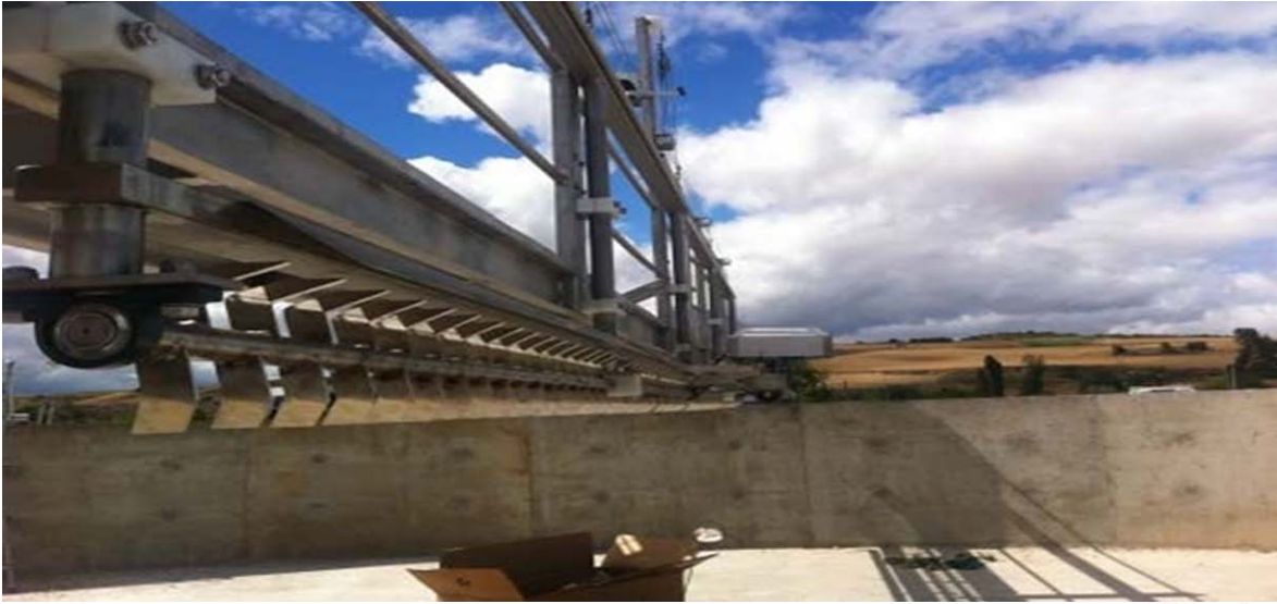
Figura 7.104. Brazo de distribución giratorio dotado de sistema de rastrillado (BIDATEK).
