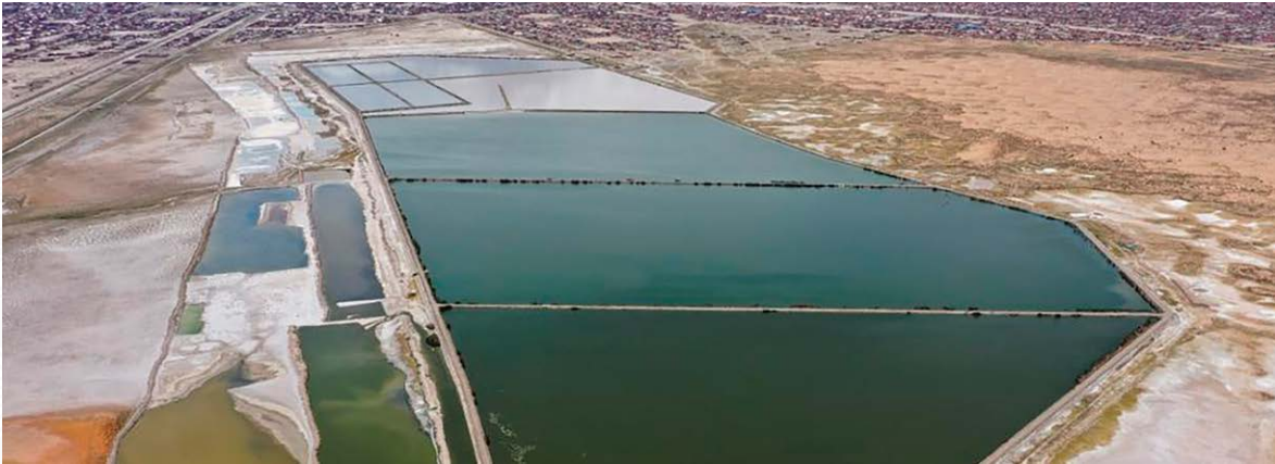
Figura 7.41. Lagunas de Estabilización (PTAR Oruro, Bolivia).
