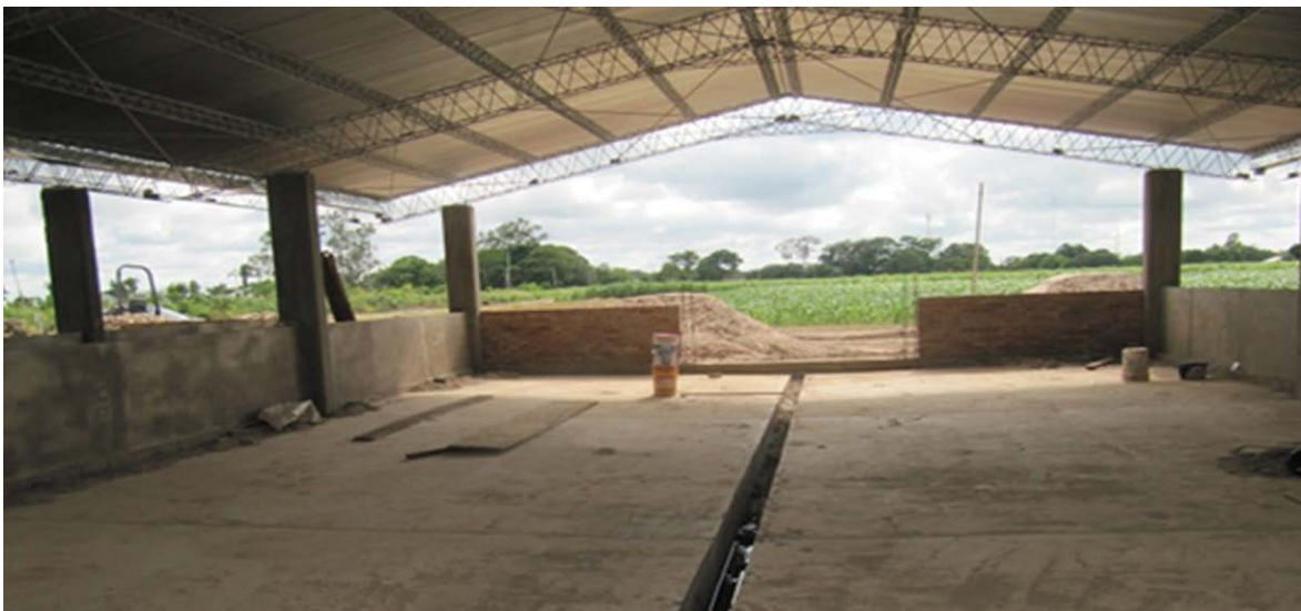
Figura 7.105. Fondo de Lombrifiltro con canal central de recogida (PTAR Fernández Alonso, Santa Cruz, Bolivia).
