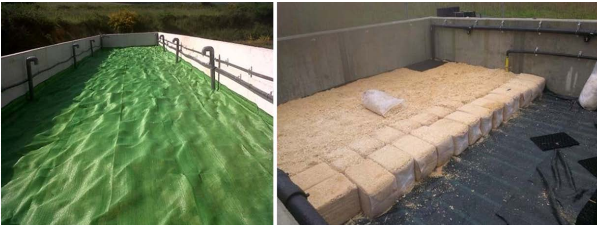
Figura 7.101. Malla de separación entre capas de sustratos filtrantes y sustrato celulósico (se observan las chimeneas de ventilación) y colocación del material celulósico) (BIDATEK).
