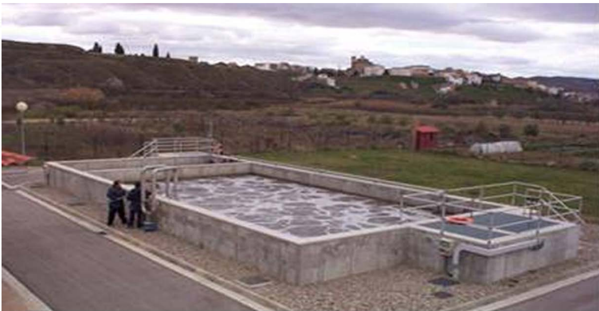
Figura 7.183. Sistema convencional de Aireación Extendida en la PTAR de Alcanadre (La Rioja, España).
