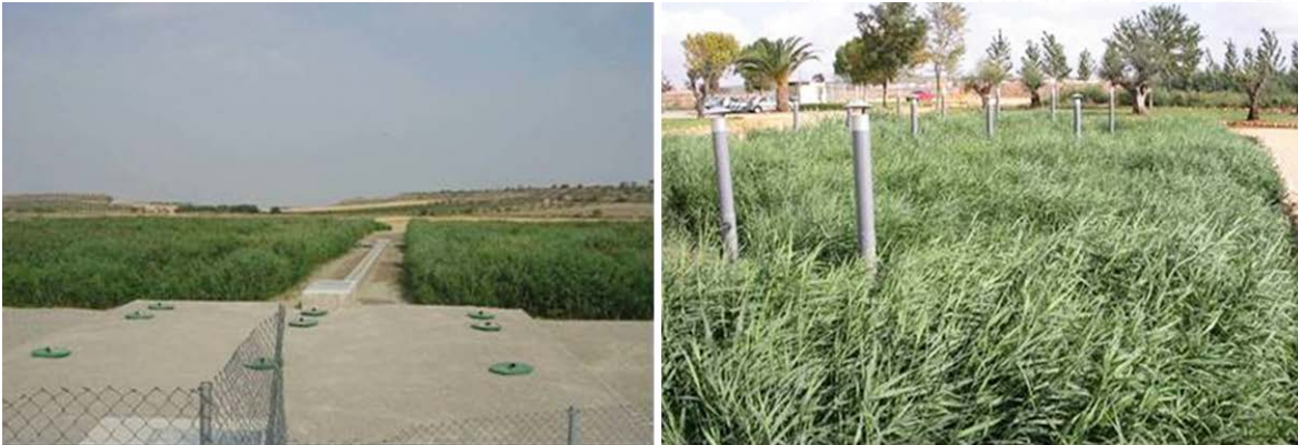
Figura 7.64. Humedal de Flujo Horizontal en la PTAR de Verdú (Lérida, España) y Humedal de Flujo Vertical en la Planta Experimental de Carrión de los Céspedes-CENTA (Sevilla-España).
