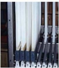
Los equipos de filtración por membranas requieren de un tratamiento previo, como puede ser una filtración por arena, para retardar su ensuciamiento.
