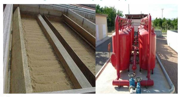
Figura 9.3. Filtros de arena por gravedad y a presión.
