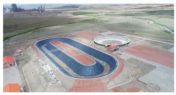
Figura 8.6. PTAR de Viacha (Bolivia), basada en Canales de Oxidación.
