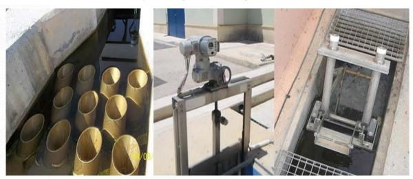
En el caso de los reactores cerrados, normalmente el caudal que pasa por ellos se bombea previamente, por lo que el caudal se regula en los equipos de bombeo, mediante variador y caudalímetro. En el caso de funcionamiento por gravedad, la regulación se lleva a cabo mediante válvula automática y caudalímetro.
